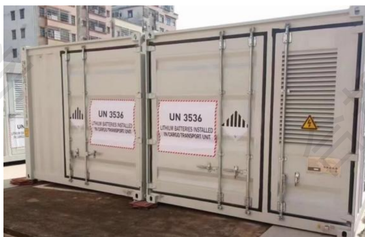
图 5 集装箱外危险货物标牌和 UN 编号示意图 (4 面均要)
